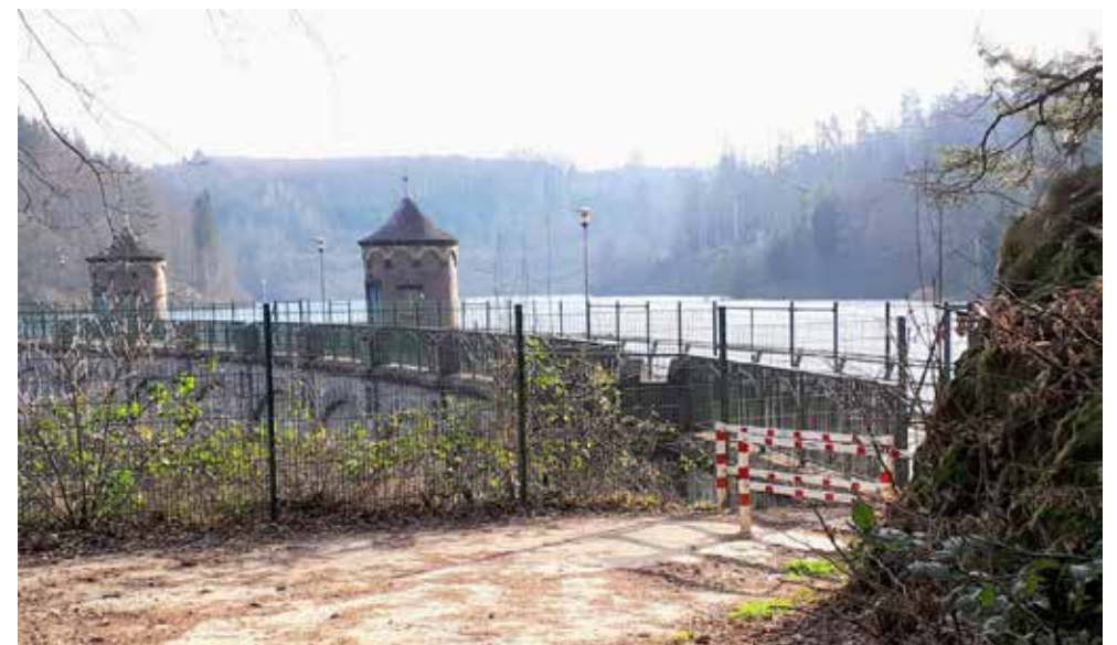
Staumauer der Sengbachtalsperre - Foto Drechsler
