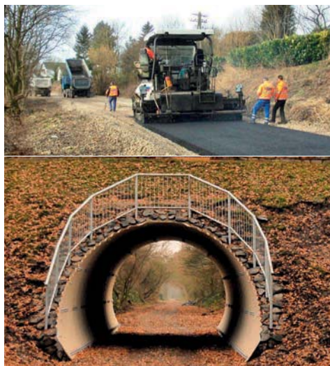
Die Asphaltsschicht wird aufgebracht (oben). Unten: Die Durchfahrt durch die Romberger Brücke.
