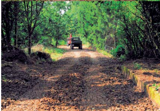
Die Strecke am ehemaligen Bahnhof Bergisch Neukirchen vorher und nachher.
