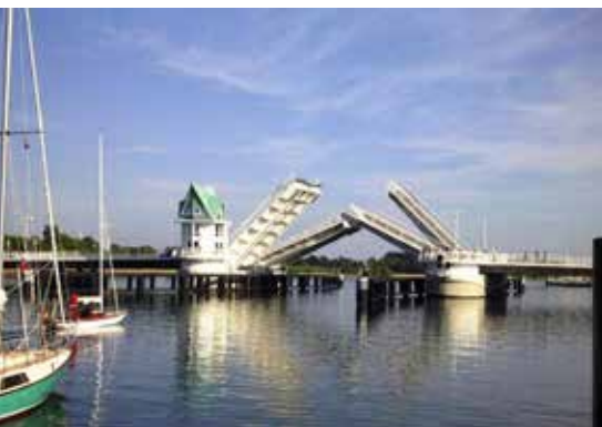
Schleibrücke in Kappeln.
