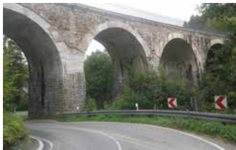
Vennbahntrasse - Viadukt bei Reichenstein
