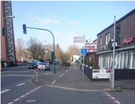
Alkenrather Straße Radweg
