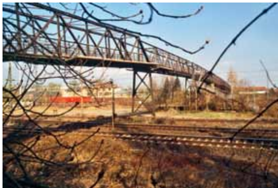
Bilder: Die neue und die alte Brücke.
