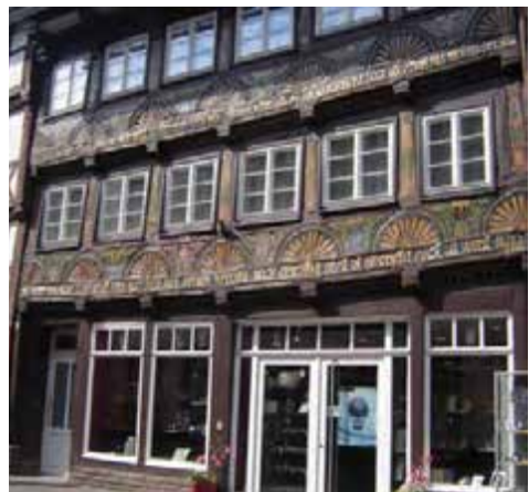
Fachwerkhäuser in Höxter.
