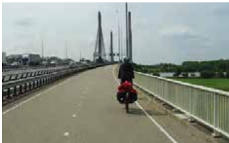
Ideal für Radfahrer: Autobahnbrücke der A 2 bei Zaltbommel über den Rheinarm Waal. Rechts: Radweg Südseite zurzeit.
