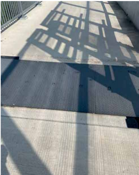
Dehnungsfuge Radweg Foto Kurt Krefft
